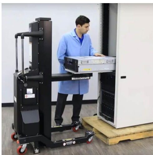
Figure 15 : Exemple d'utilisation d'un server lift
