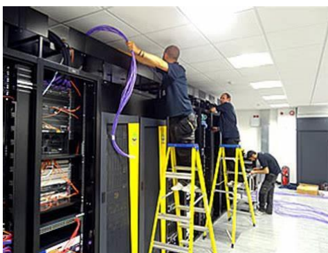
Figure 17 : Technicien tirant des câbles
